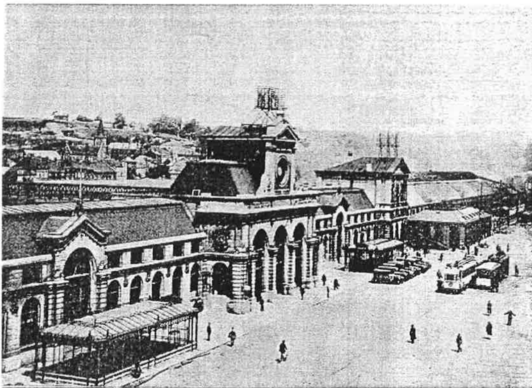
Gare de Namur : avant les transformations (Photo SNCB, échelle de reproduction : 110%)
