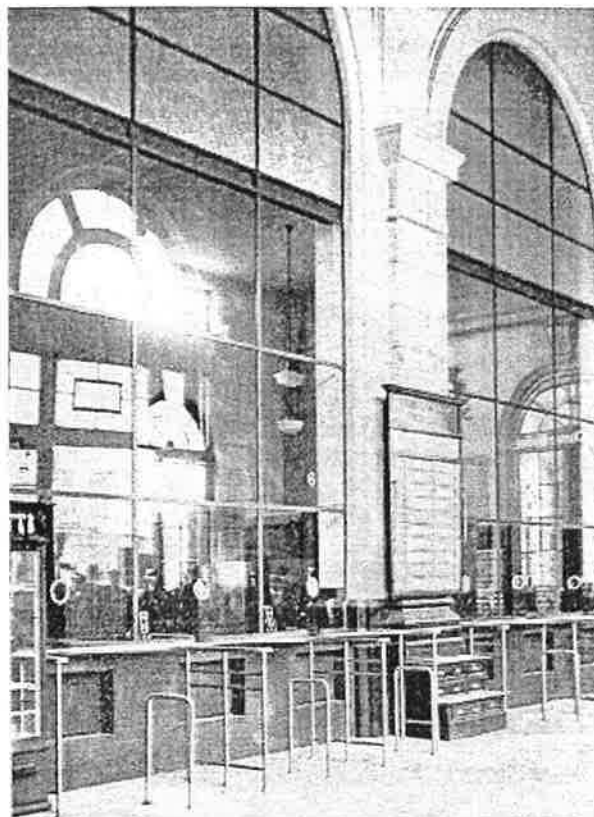
Guichets après transformations, vue côté salle des pas perdus.
